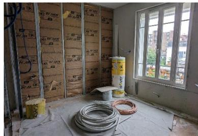
La maison possède 4 façades qui donnent sur l'extérieur dont une façade avec les briques pleines visibles et un soubassement en pierres. L'isolation par l'extérieur n'était donc pas possible afin de conserver l'esthétique extérieure. Une isolation par l'intérieur a donc été réalisée.
