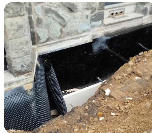
Membrane d'étanchéité sur un mur contre terre existant
