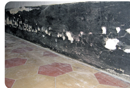
Humidité ascensionnelle au pied d'un mur avec décollement de peinture
