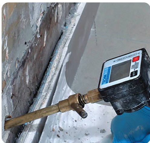
Injections de produit hydrophobe contre l'humidité ascensionnelle dans un mur de cave © Technichem
