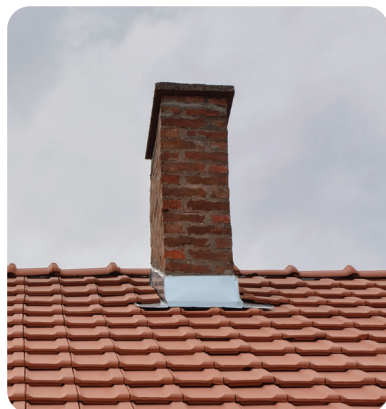
Solins au raccord avec les tuiles
