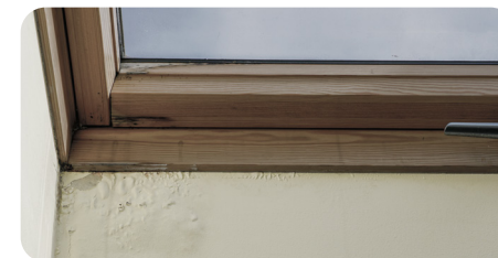
Cloquage de la peinture de l'encadrement d'une fenêtre de toit en raison d'un mauvais raccord entre celle-ci et la toiture inclinée
