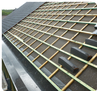
Membrane de sous-toiture placée sous les tuiles © Isoproc
